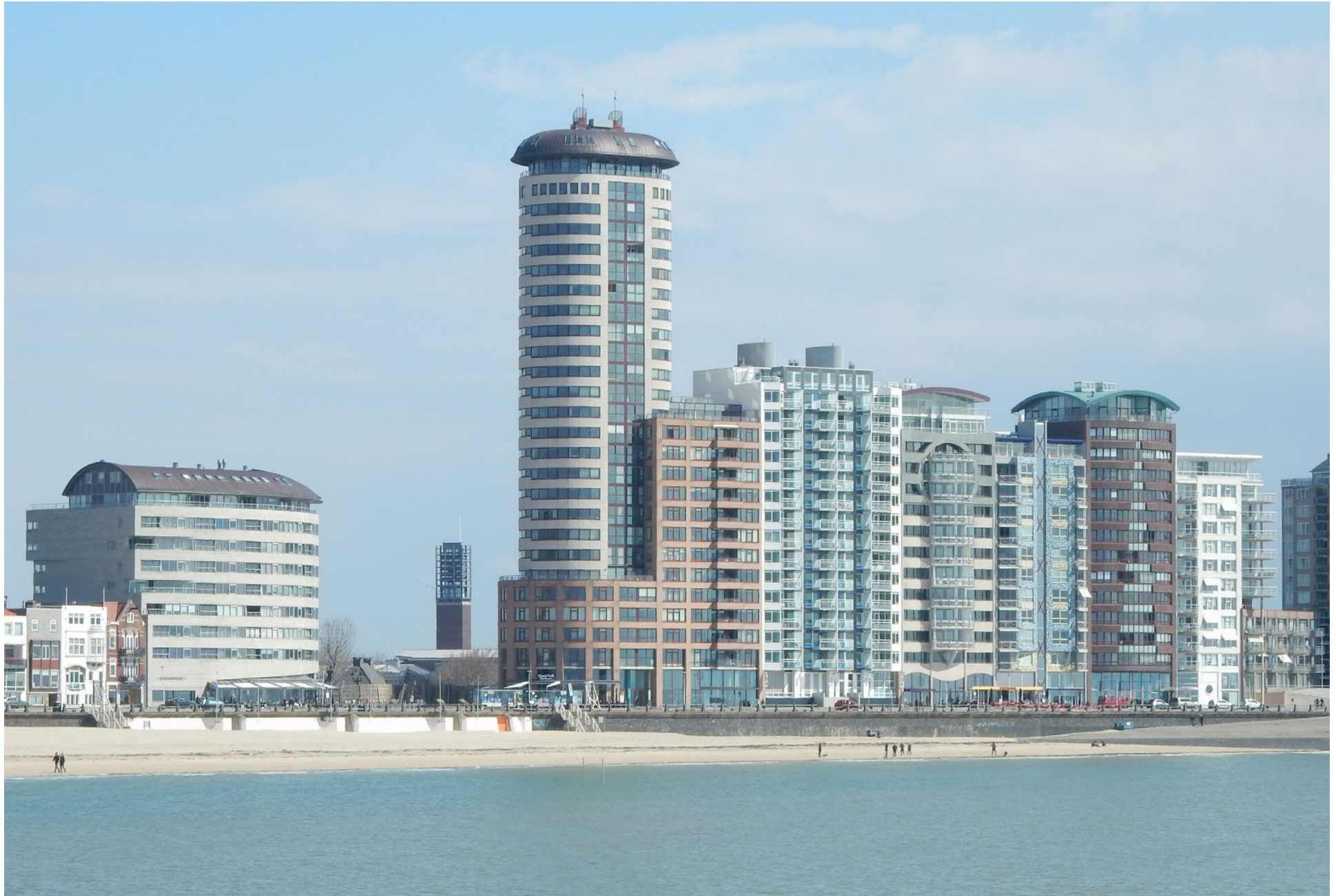
De dubbele begane grond laag van het Vliissings Model is duidelijk te zien in het aanzicht van de bebouwing langs boulevards Evertsen en Bankert.
